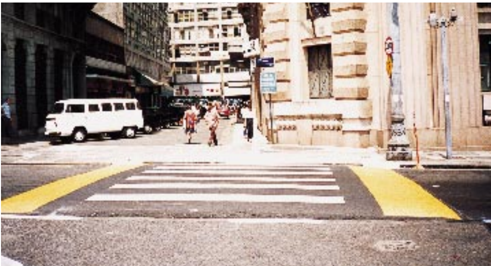
A faixa de pedestres na altura da lombada garante proteção adicional à travessia.
