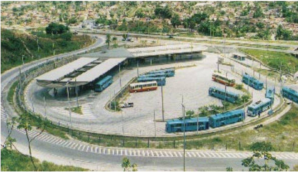
Terminal de transferência do sistema estrutural integrado de Recife, onde ocorre a integração em área paga do sistema trólebus para o ônibus comum.
