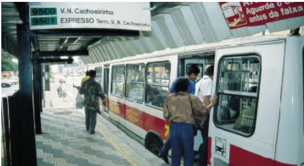
A faixa exclusiva junto ao canteiro central, com ônibus com portas à esquerda e plataformas elevadas, compõe uma solução de baixo custo, aproveitando o canteiro já existente (corredor Vila Nova Cachoeirinha, São Paulo).
