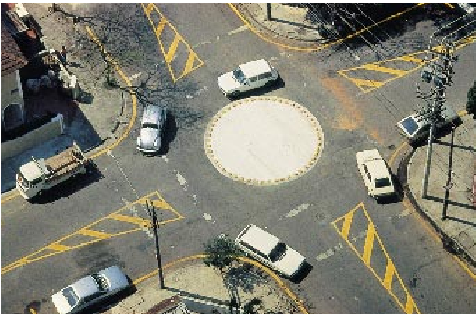
As minirotatórias são dispositivos de controle dos conflitos nas interseções para melhorar a segurança de trânsito onde não é necessário a instalação de semáforos.
