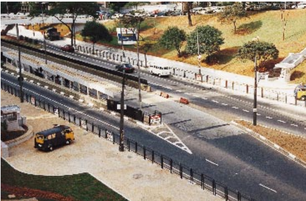
Em situações de risco de acidentes nas travessias, a implantação de gradis direciona o fluxo de pedestres, aumentando sua segurança (av. 9 de Julho, São Paulo).
