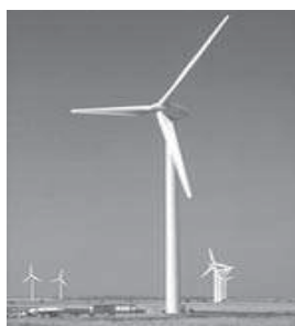
Aerogerador com Eixo Horizontal
