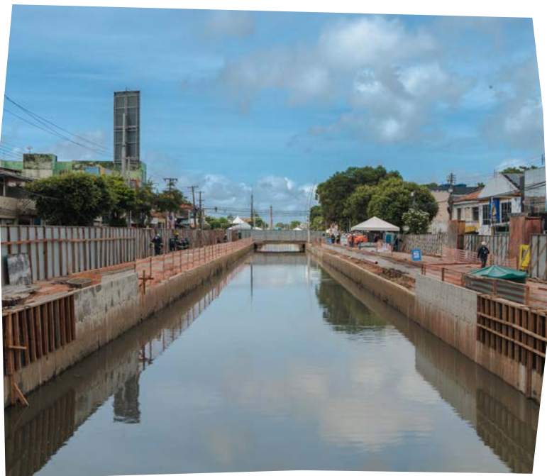
Terminal Fluvial da Tamandaré, em Belém (PA).| Foto: Acervo BNDES/Diego Formiga.
